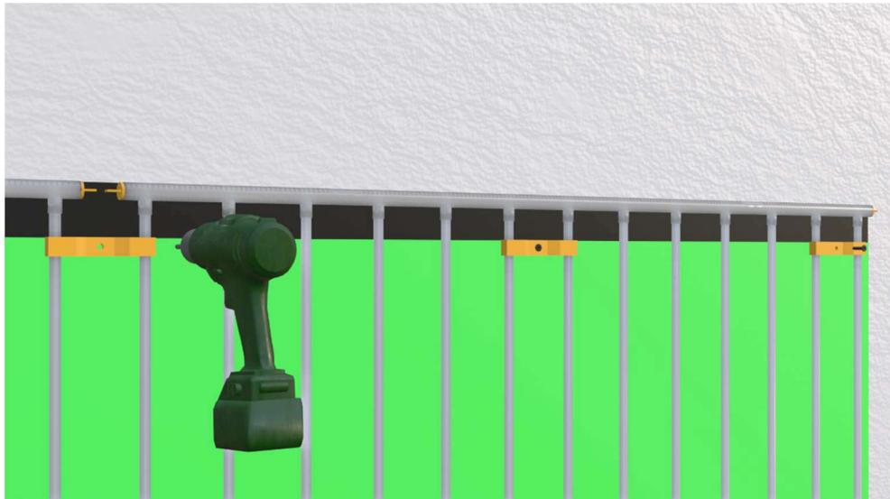
Im Anschluss wird das nächste Teilfeld mit einer Kunststoffschweißung am Sammler verbunden und ebenfalls an den oberen Halteklammern an die Wand angebracht.
